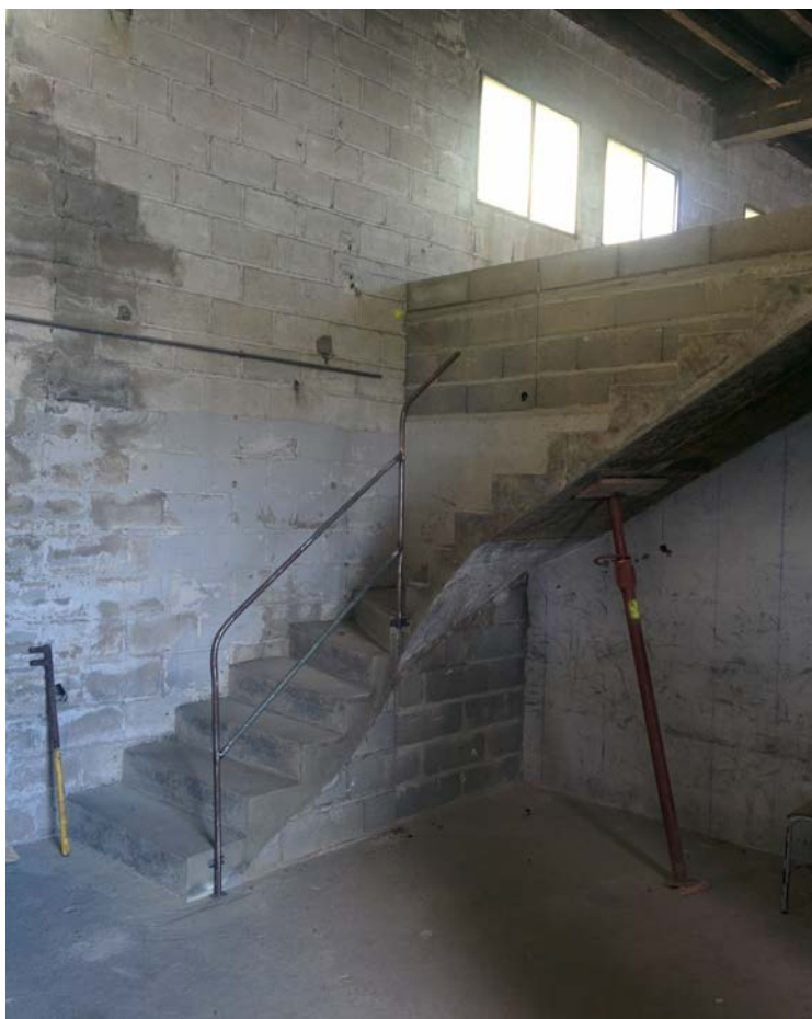
Réalisation d'un escalier en béton pour accéder à l'étage
