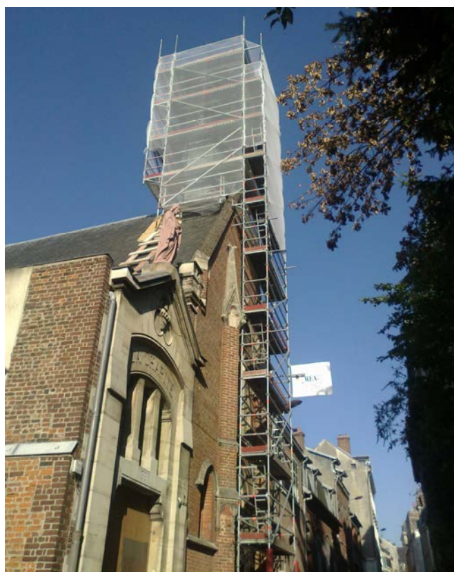
Le clocher durant les travaux
