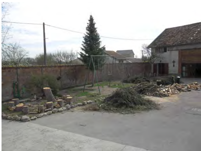
Les travaux dans les espaces verts de la cour
