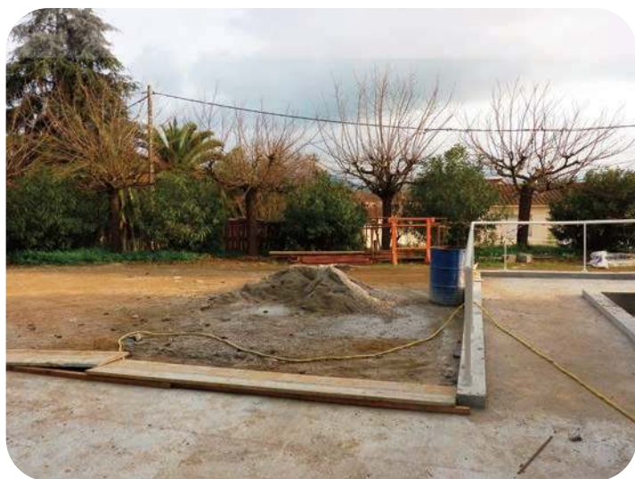
Parking et rampe d'accès
