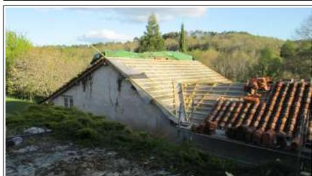
La toiture de l'hôtellerie a été démontée et reposée correctement, après isolation des combles. Il reste à refaire le toit et la charpente d'une petite grange prévue comme buanderie et comme atelier, et la couverture d'une autre annexe adaptée pour devenir l'infirmerie ; cette partie est abritée par une simple bâche depuis des années.
