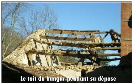
Le premier chantier urgent concernait les dépendances. La charpente et le toit du hangar, qui menaçaient de s'effondrer, ont été refaits. Au rez-de-chaussée doit être aménagé un local technique pour abriter la chaudière, un bûcher, etc ; nous réservons les 80 m<sup>2</sup> du 1<sup>er</sup> étage à la bibliothèque, quand Dieu permettra son installation, avec un accès direct depuis la maison.
