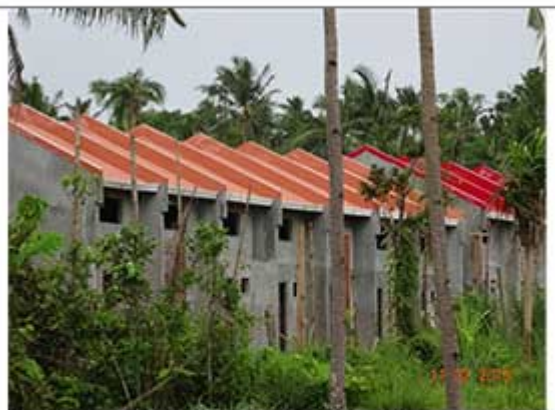
Quelques rares maisons en construction
