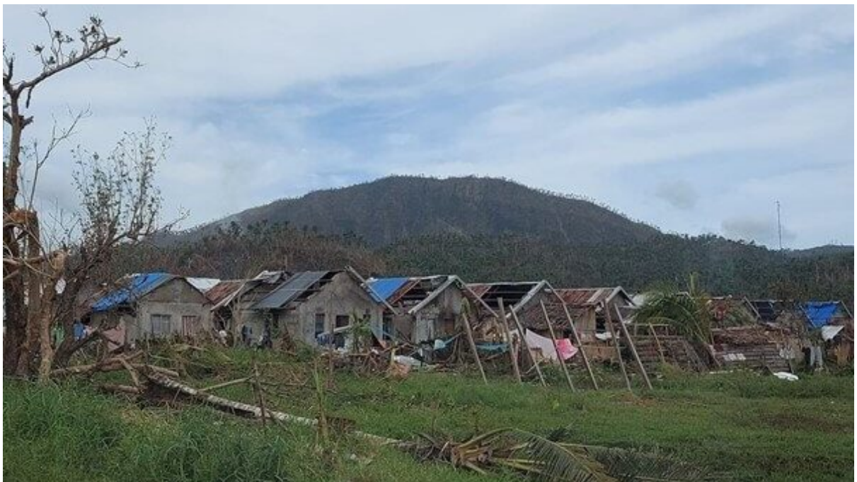
Tous les toits de la tribu Mamanwa ont été endommagés, sauf celui que protégeait la Vierge. Les païens se posent des questions
