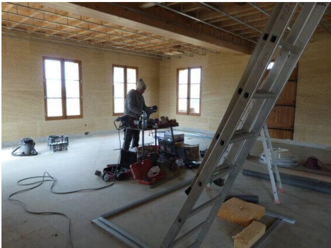
Pose des descentes pluviales. A l'étage de l'hôtellerie début du cloisonnement des cinq
