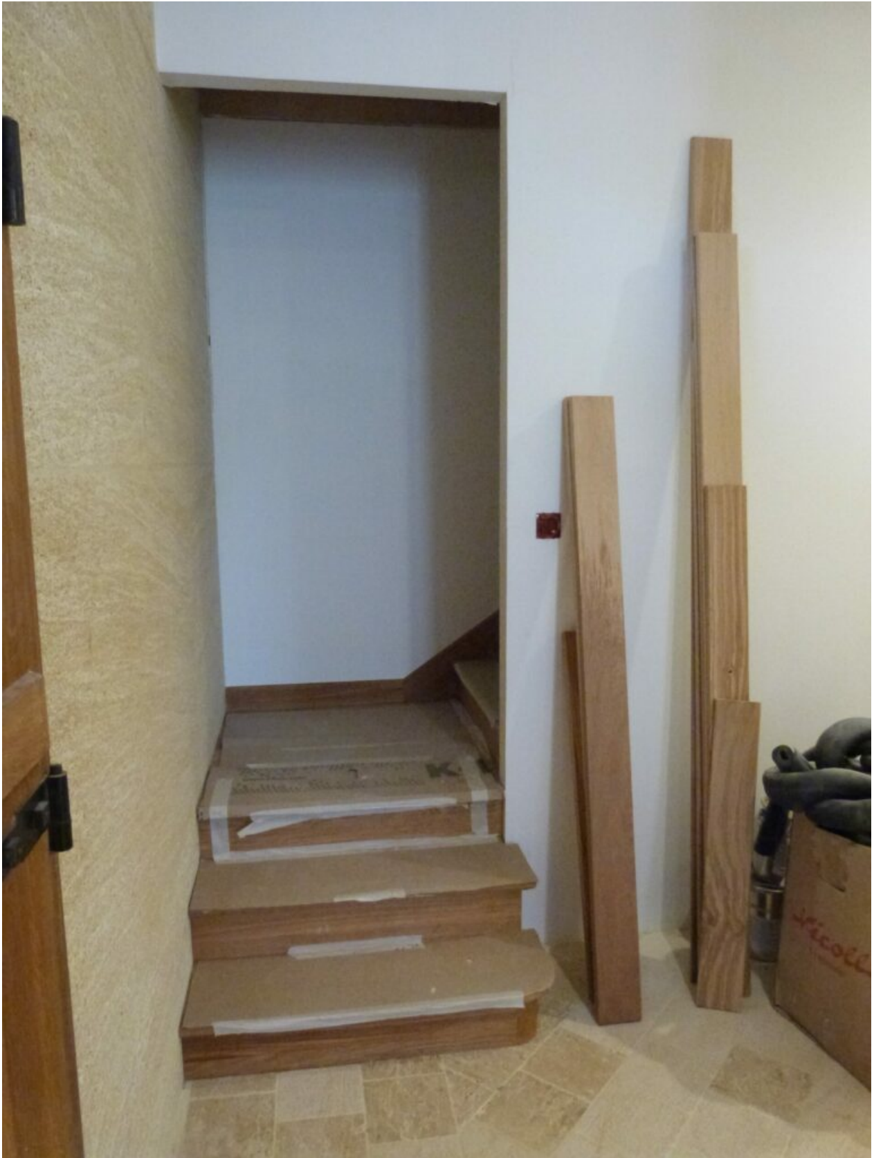
Pose de l'escalier à Sainte Elisabeth
