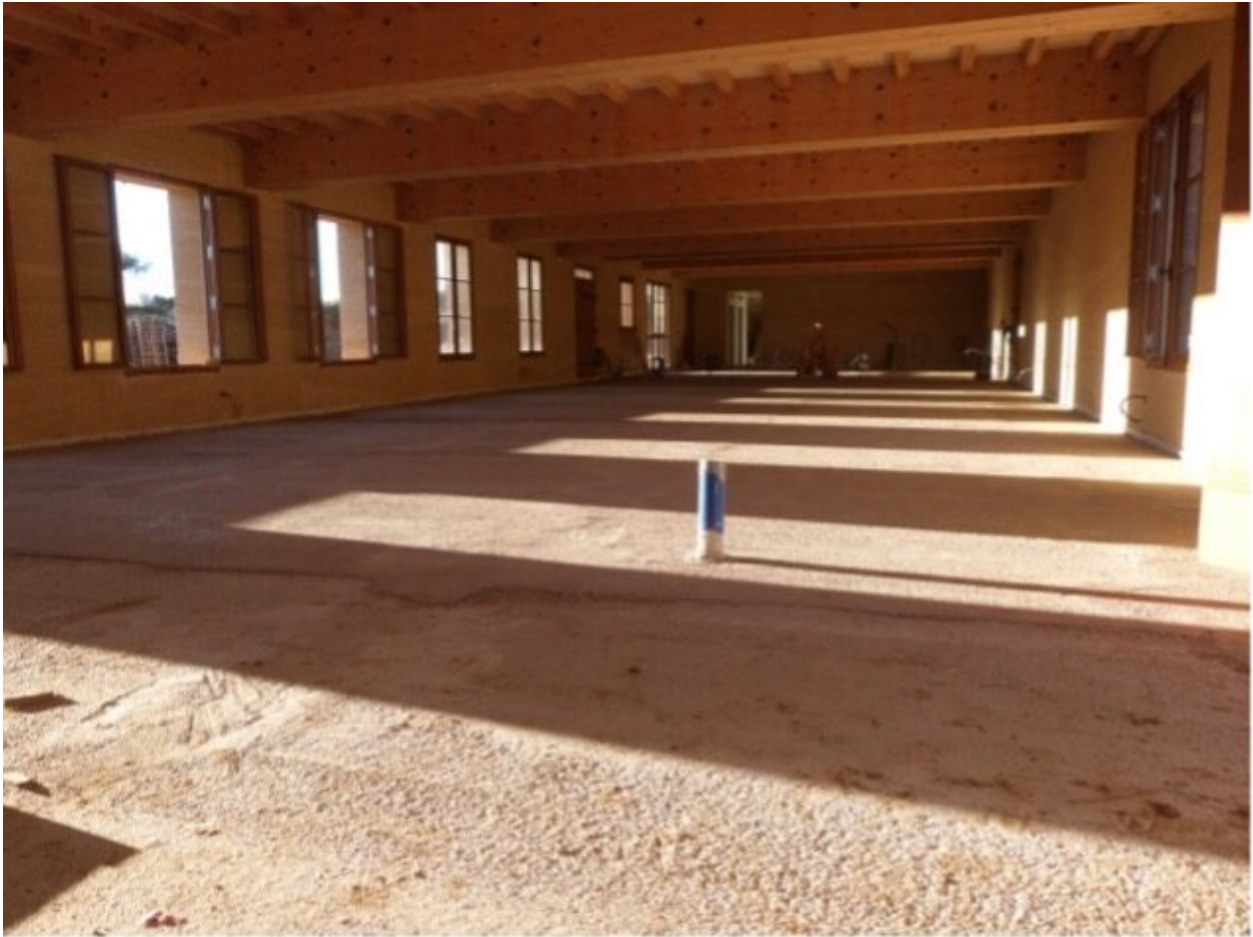
Le rez- de- chaussée avant la pose des cloisons : les préparatifs du sol.
