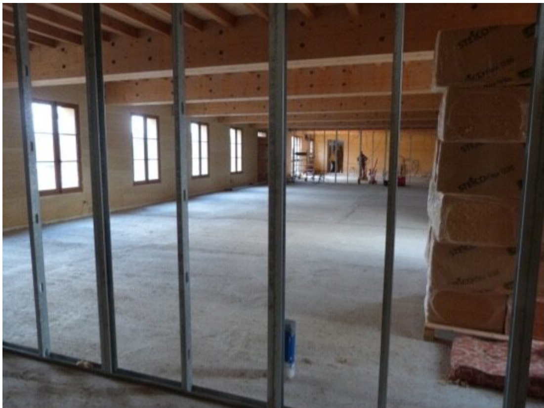
Les cloisons intérieures délimitent le couloir d'entrée, le réfectoire et la cuisine. On voit les ballots d'isolant en laine de bois pour le plafond
