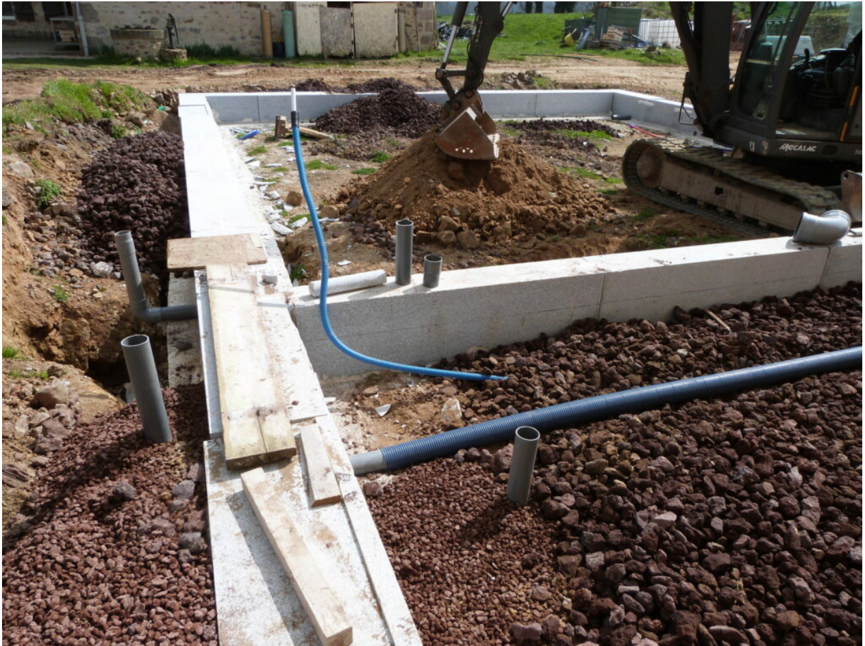
Les pourtours extérieurs et les sols intérieurs des bâtiments sont comblés de pouzzolane
