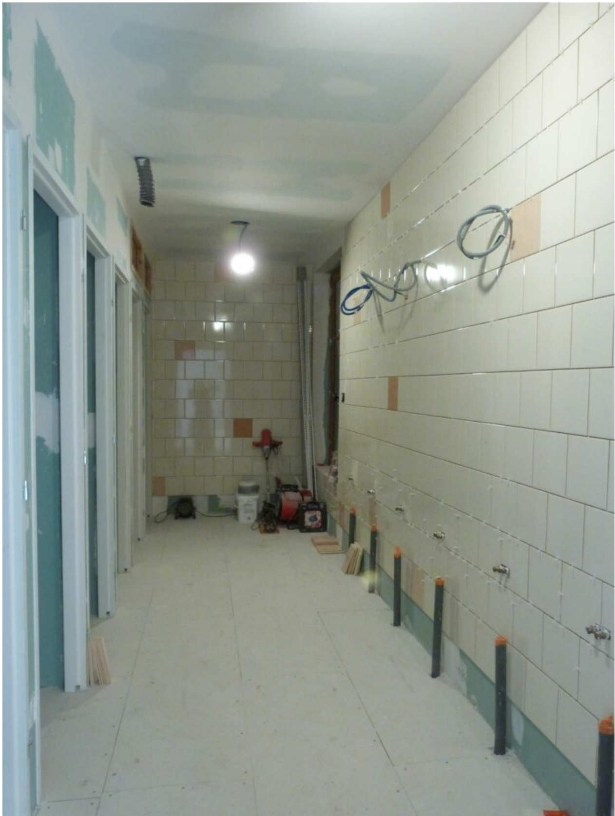
La pose de la faïence aux murs
