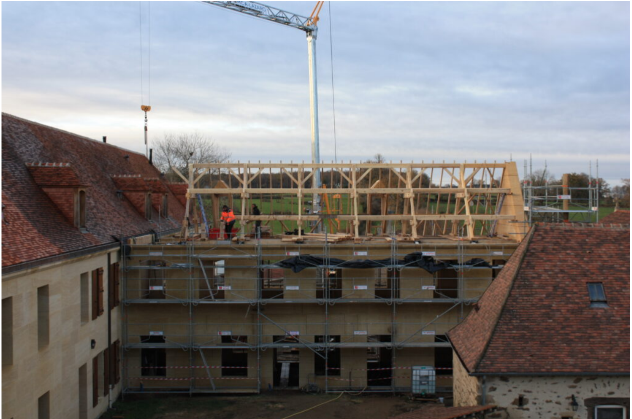
Ouverture et jonction au niveau des noues
