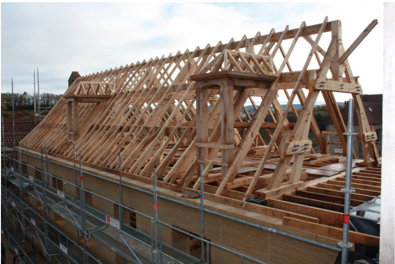
Assemblage des fermes et des pannes
