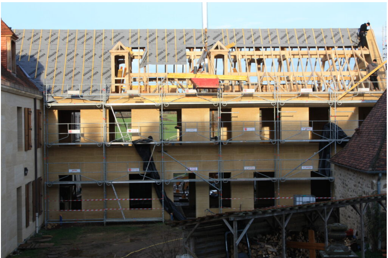
Pose des chevrons et des liteaux en attendant les tuiles
