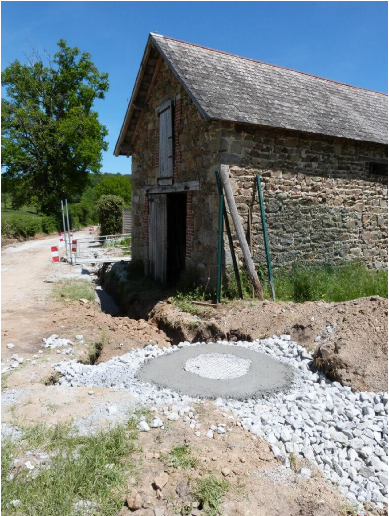
Mise en place des évacuations (eaux de terrain et eaux de pluie)
