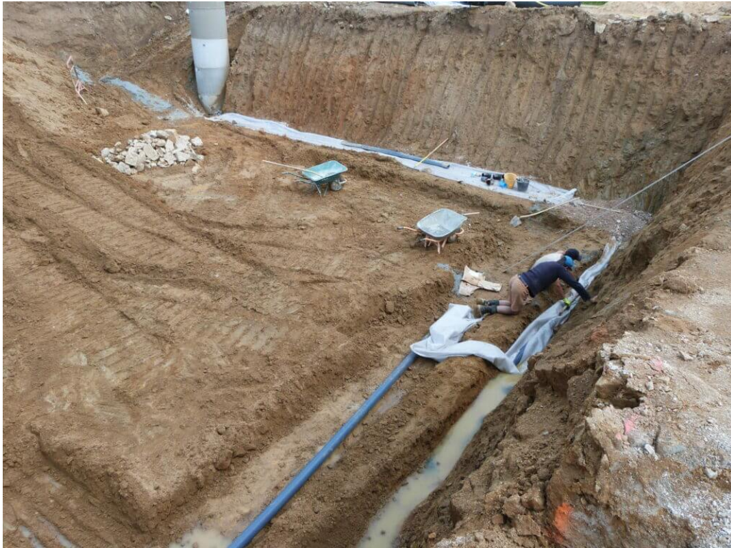
Pose des drains pour l'évacuation des eaux de terrain
