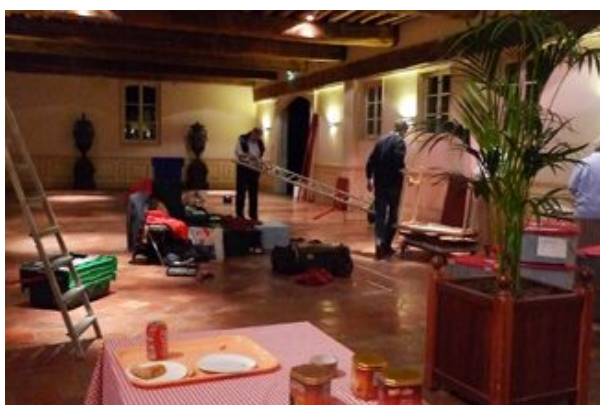
On démonte l'électricité
