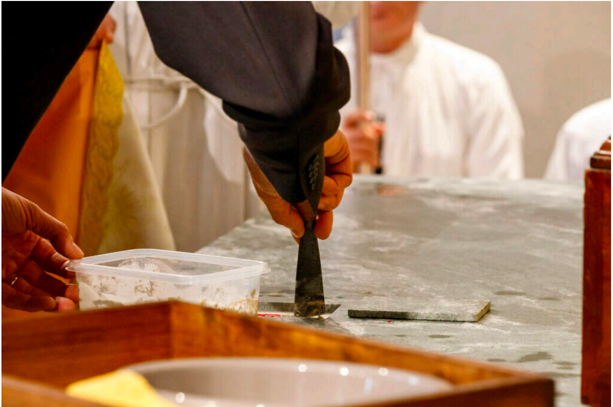
Le maçon applique le ciment
