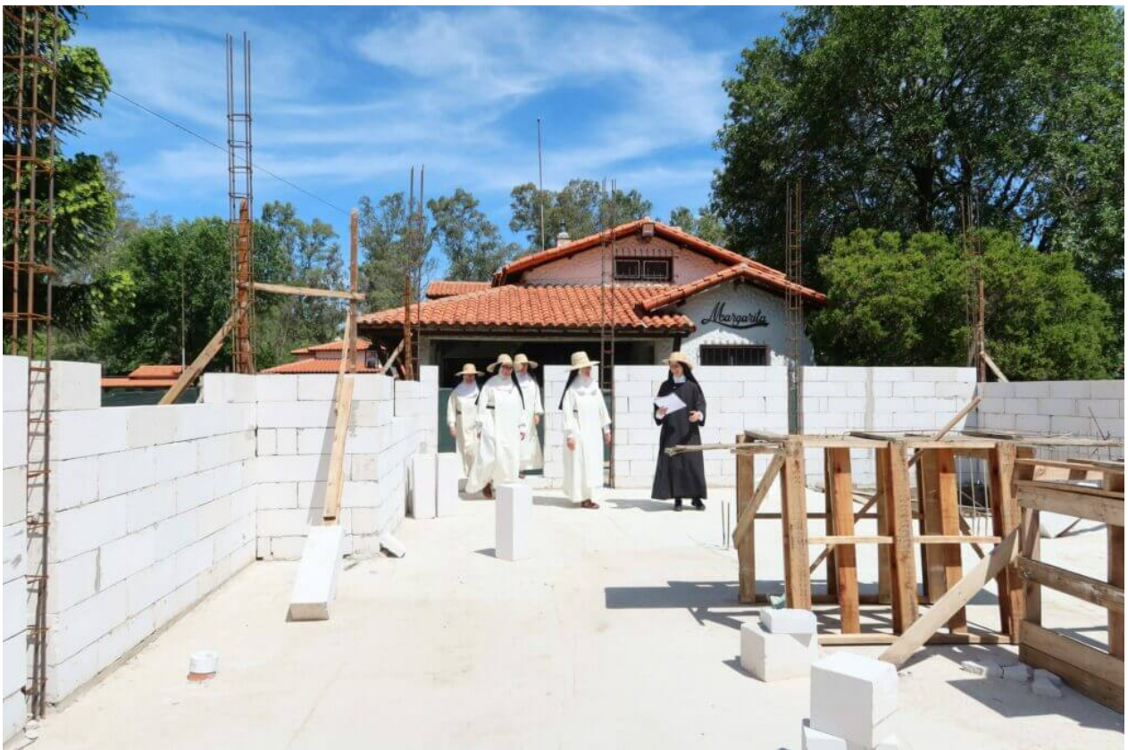
Une Sœur fait visiter le chantier à nos voisines Dominicaines
