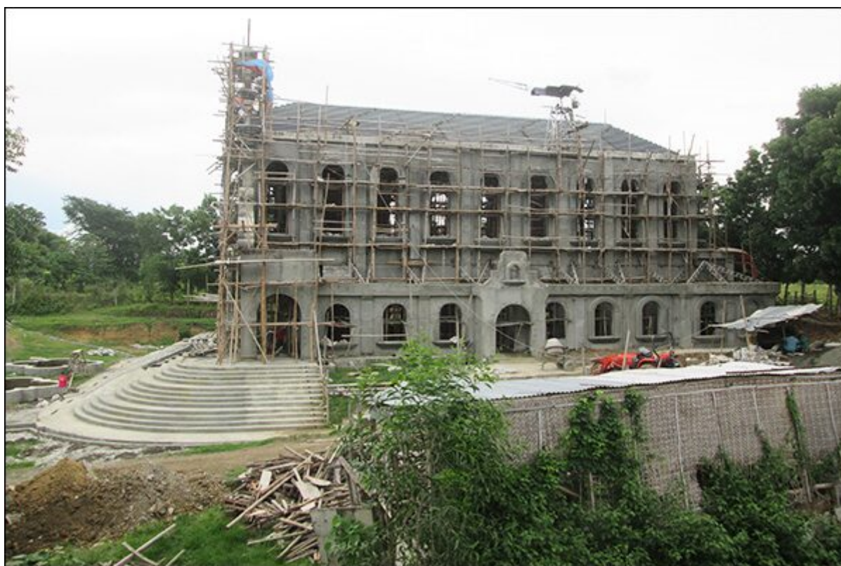
La toiture de l'église du noviciat Saint-Bernard en passe d'être terminée
