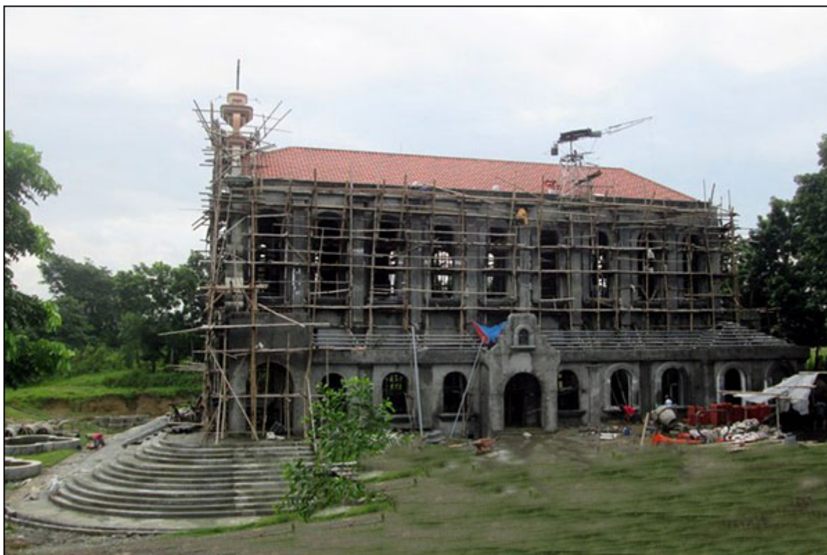
La toiture de l'église du noviciat Saint-Bernard en voie de finition : Deo gratias !
