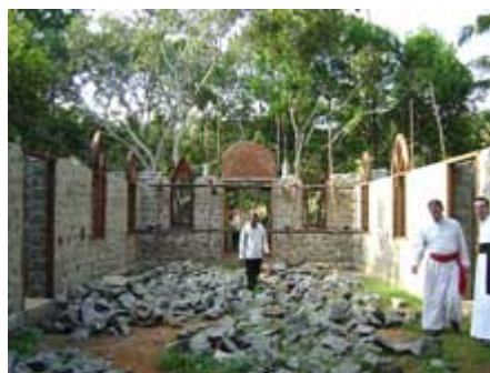
Construction d'une église en pierre
