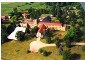
Une vue d'ensemble du
