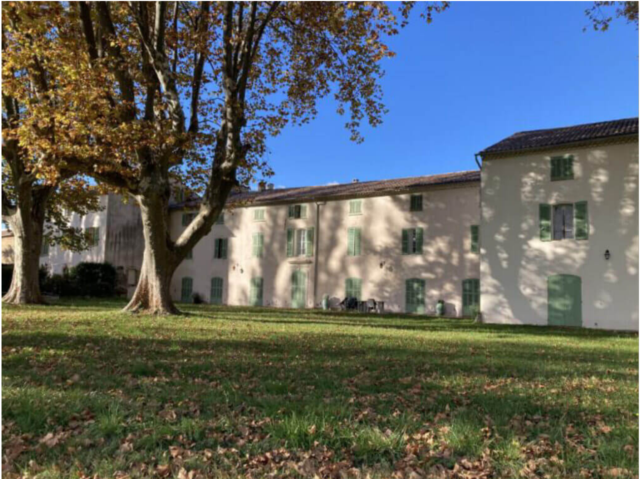
Le bâtiment principal
