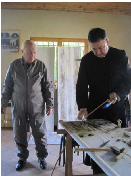
Commencement de la réfection des volets... Des volontaires sont attendus pour la poursuite
