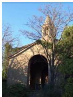
La chapelle (à restaurer)
