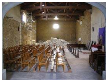
Aménagement provisoire, pendant les travaux
