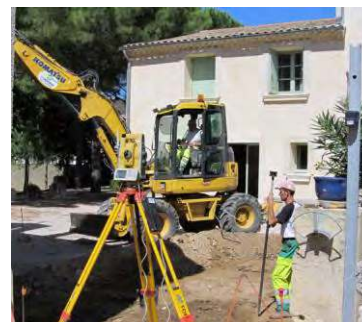
TRAVAUX DU PARVIS A FABREGUES
