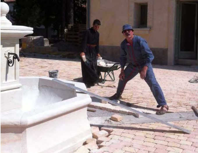
TRAVAUX DU PARVIS A FABREGUES
