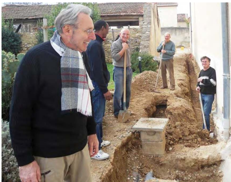
TRAVAUX DU PRIEURÉ : DEVOUEMENT ET BONNE HUMEUR !
