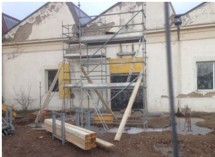
Coulage des fondations du clocher
