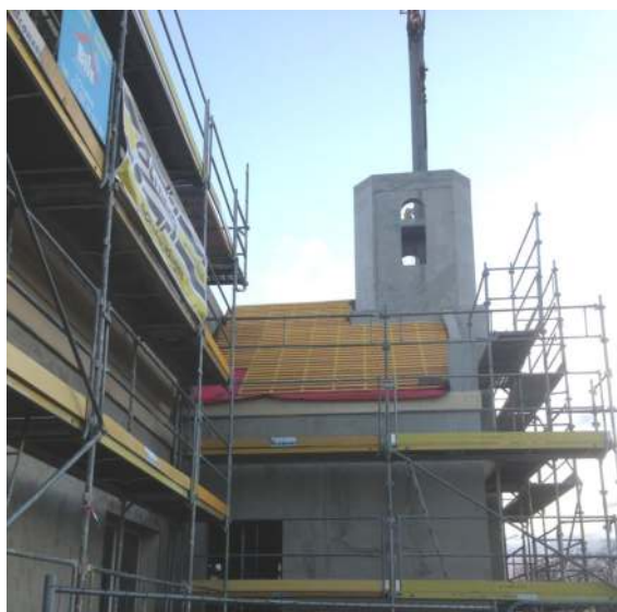
Pose de la charpente derrière le clocher
