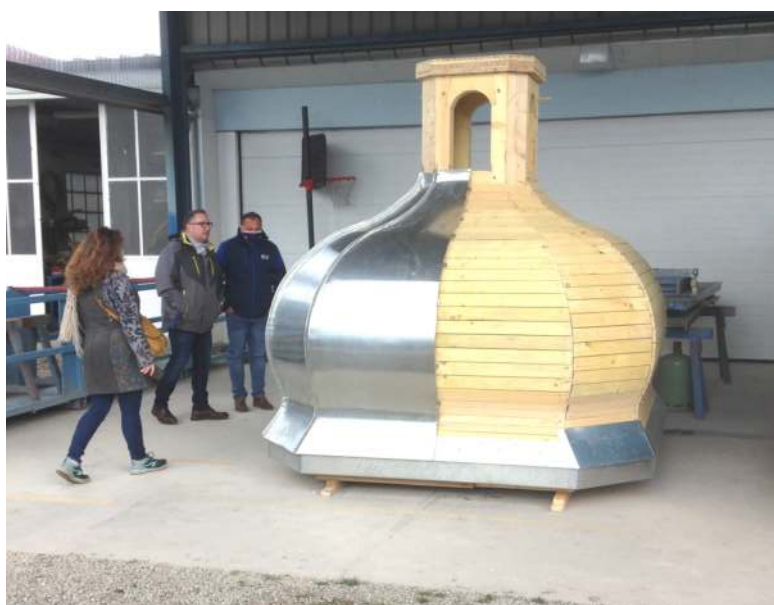
Couverture du bulbe du clocher (entreprise Bilz)
