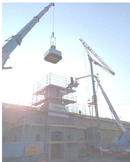
Mise en place du bulbe du clocher
