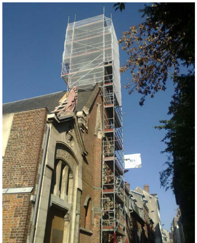
Le clocher durant les travaux
