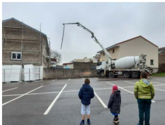
Partie émergée des travaux : l'extérieur
