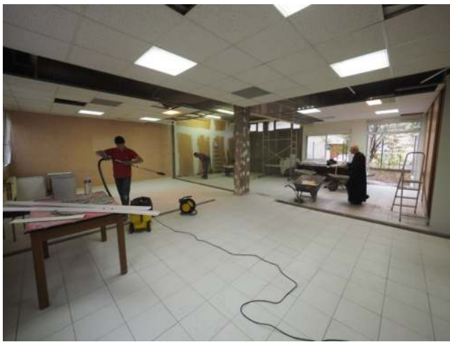
Décloisonnement de la salle paroissiale
