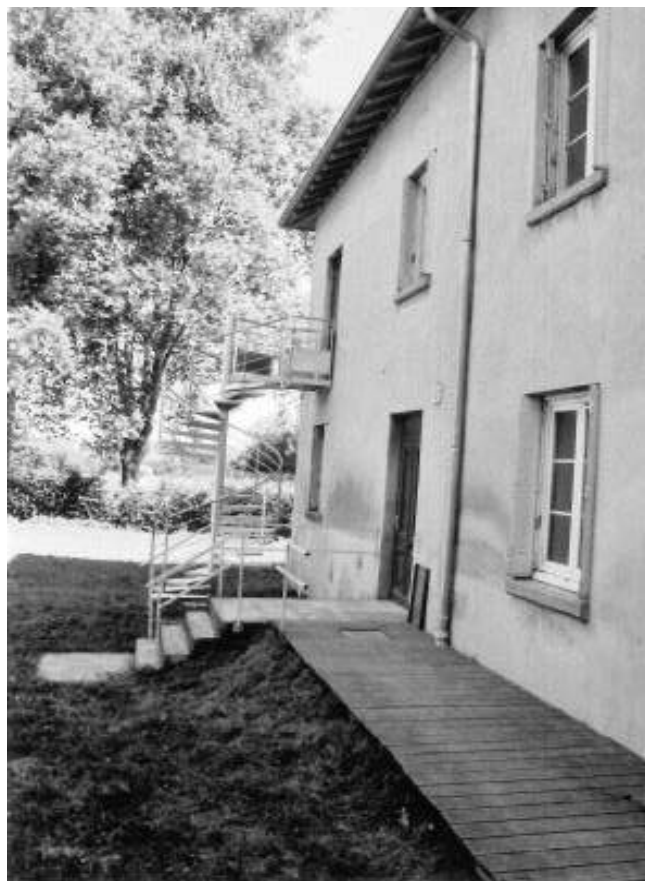
Escalier de secours de la salle d'étude
