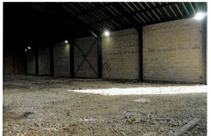
200 m 2 de parpaings posés en un mois
