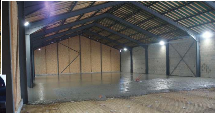
La dalle tant attendue : de 7h00...à 23h30!
