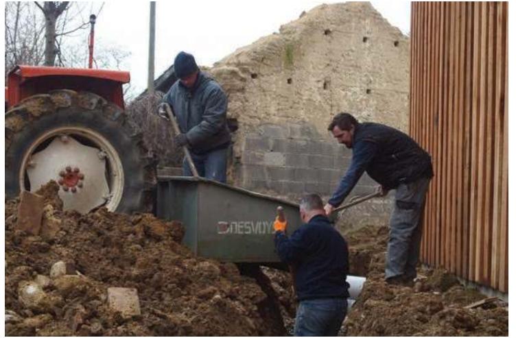
Installation des drains extérieurs
