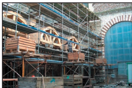
Reconstruction de la nef
