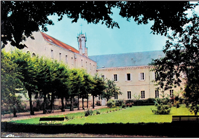
La Maison Lacordaire à Flavigny, avant la construction de l'allée couverte le long de la chapelle par l'abbé Coache.
