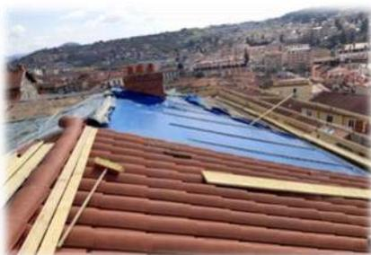
La consolidation de la charpente, la réfection de la toiture et la pose des huisseries de la chapelle sont réalisées. Les rejangots et les linteaux des fenêtres coté habitation ont été repris, et les fenêtres sont commandées.
