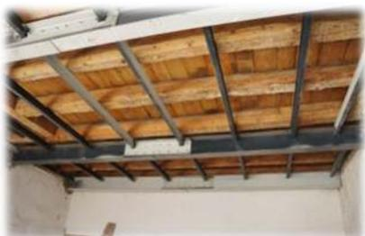
Les entreprises s'attèlent maintenant aux étages d'habitation afin de consolider les planchers et les plafonds. Après la pose des hourdis et des gaines électriques, une dalle de béton sera coulée.
