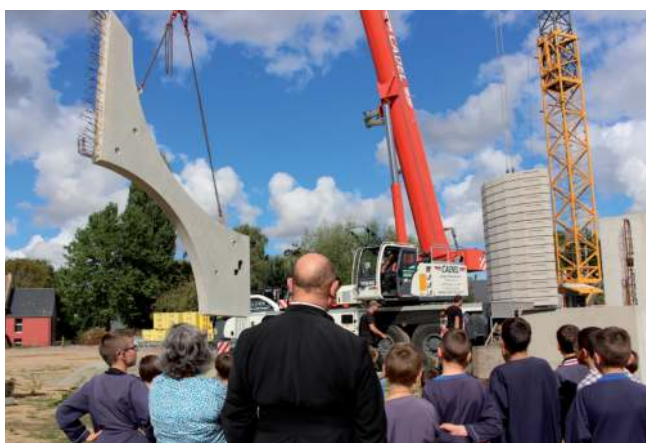
La pose des arcs boutants
