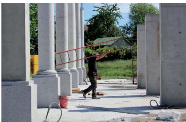
Colonnes et contreforts
