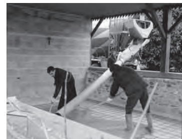
Travaux d'aménagements du prieuré
