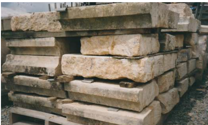
Les 220 tonnes de pierres numérotées et entreposées sur palette
