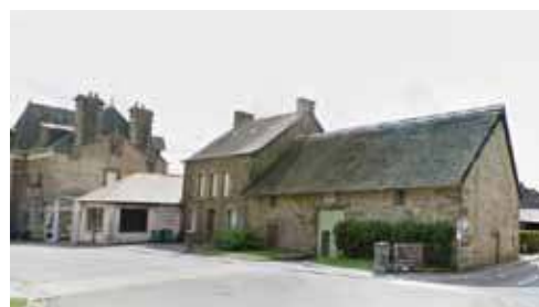
Maison Barbedette à côté de la grange de l'apparition
