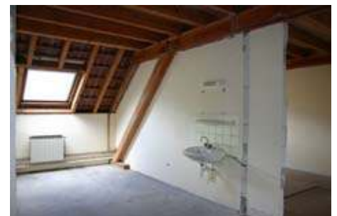
Vue intérieure d'une chambre au 4 e étage après les démolitions.
