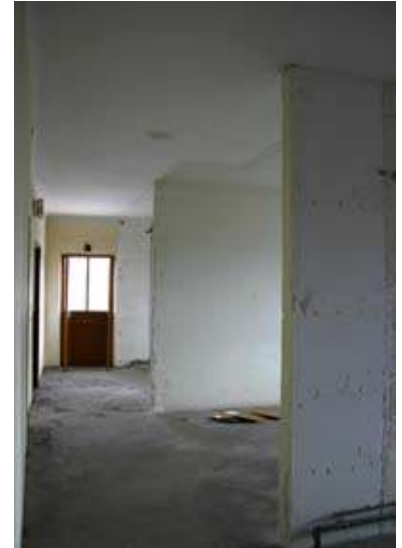
Vue intérieure d'un couloir après les démolitions.
