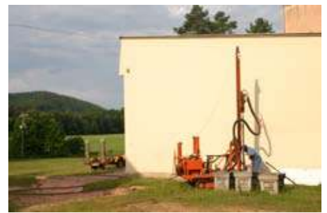
Sondage au sol pour vérifier la solidité du terrain en vue des futures constructions des escaliers extérieurs.
