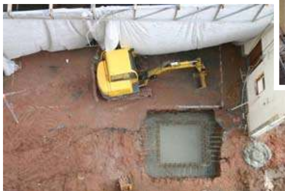
Fondations de l'ascenseur, vue de haut.
