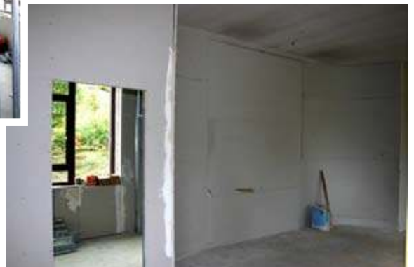
Le nouveau fond de la chapelle qui aura un vrai chœur, et derrière..., un oratoire et une sacristie.
