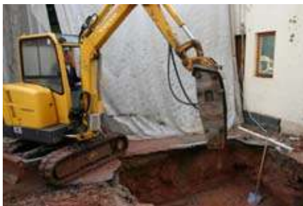
La pelleteuse creuse les fondations de l'ascenseur.
