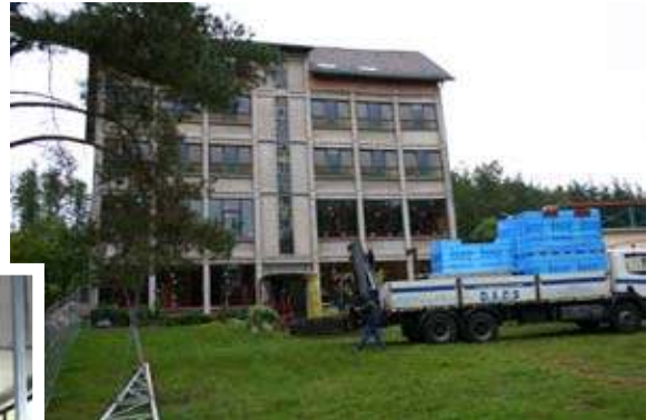
Un déchargement de plaques de plâtre et d'isolation.
