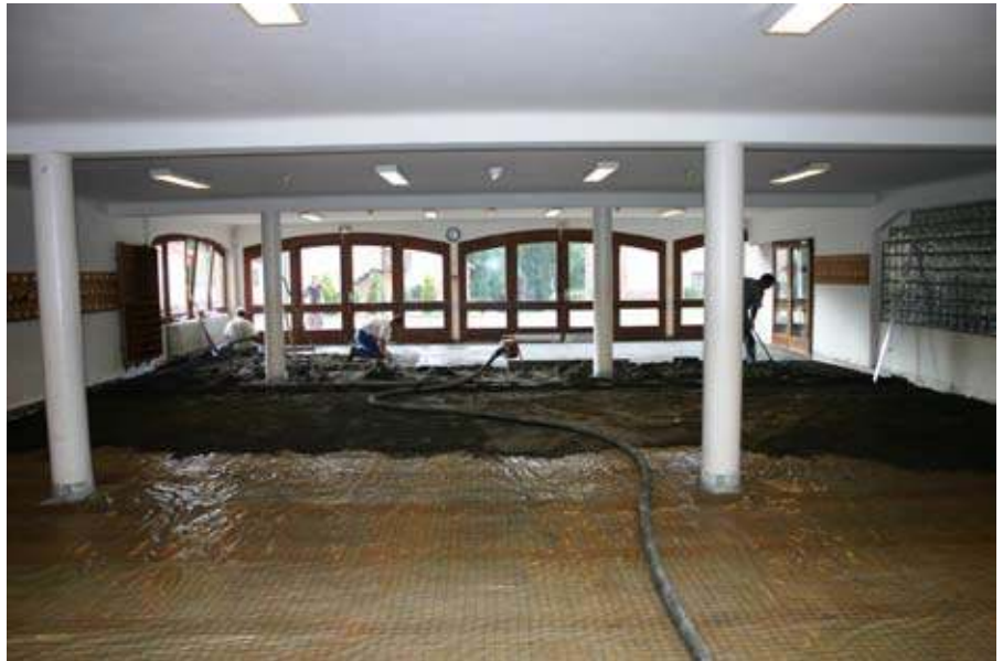
Réfection du carrelage du réfectoire en cette fin de vacances.
