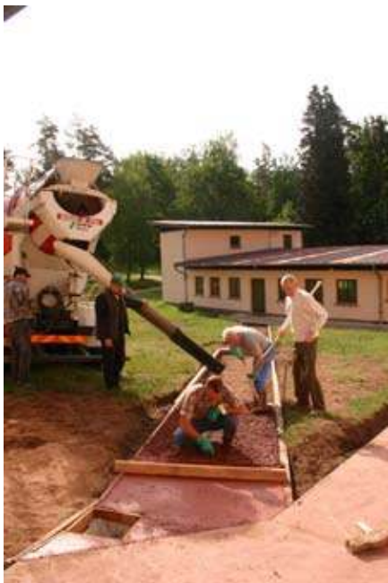
Nos bénévoles tirent le béton pour le trottoir reliant la salle de permanence
