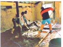
Dans le projet des cinq chambres supplémentaires aux combles de cette maison, une étape importante a été réalisée par le bétonnage de la moitié du sol, nous permettant ainsi de déplacer les matériaux sur un sol solide et de libérer l'autre partie des combles. Tous ces travaux achevés sont autant d'étapes inscrites par votre charité au Ciel.
