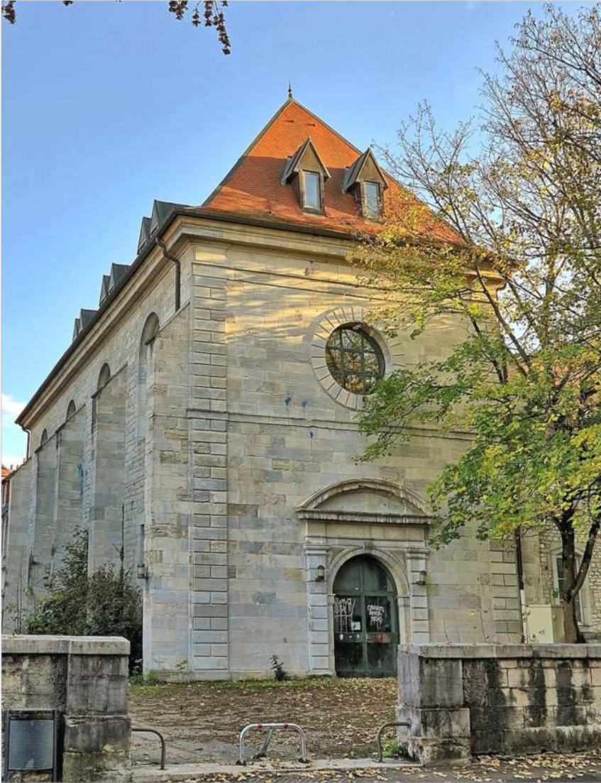
Chapelle des Visitandines, Besançon (25), à restaurer
