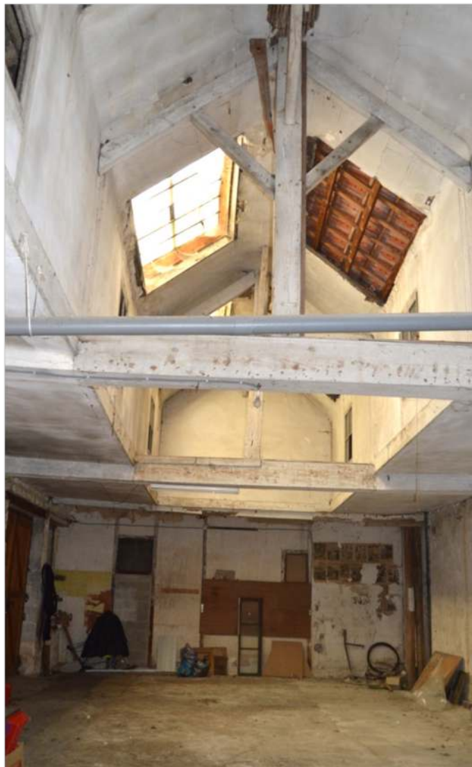
Future chapelle de Joinville (52), à aménager
