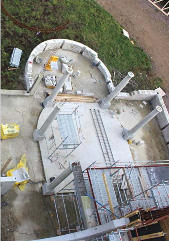
Construction de la nouvelle chapelle Notre-Dame Auxiliatrice à Gavrus (14)
