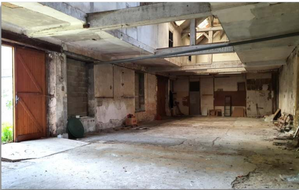
Future chapelle de Joinville (52) à aménager
